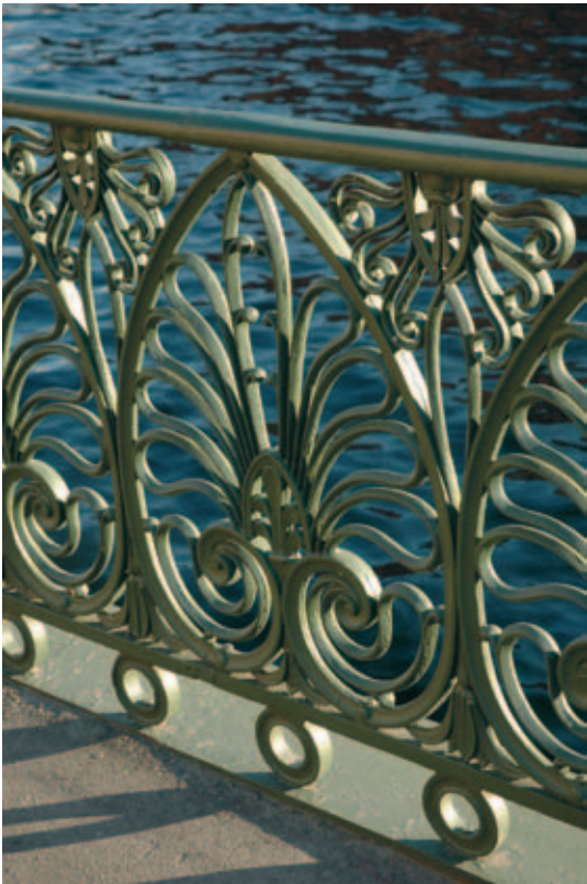
Решетка Демидова моста, Санкт-Петербург
